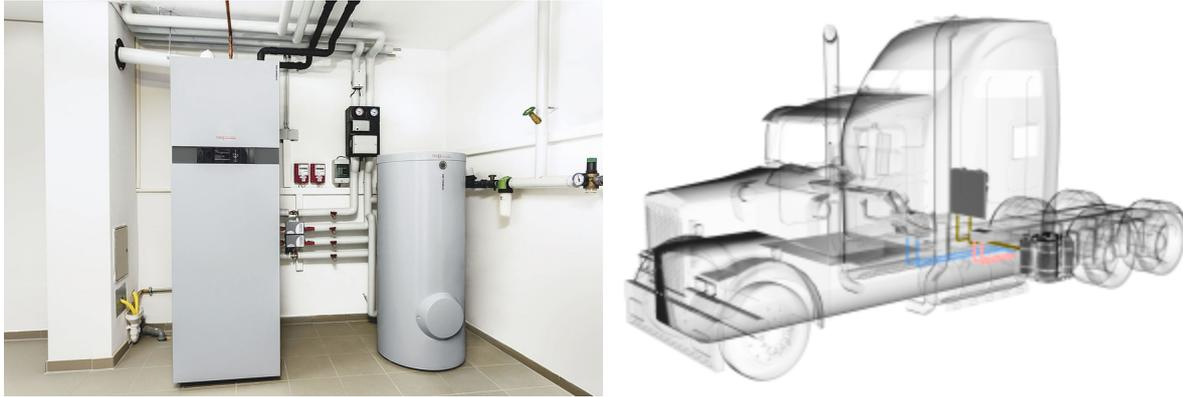
Abbildung 1.1: Bestehendes System einer Adsorptionswärmepumpe für die Warmwasserbereitstellung (links, Viesmann (2019)) und das Konzept einer Adsorptionskältemaschine für die Klimatisierung der Fahrerkabine (rechts, MAHLE (2018))
